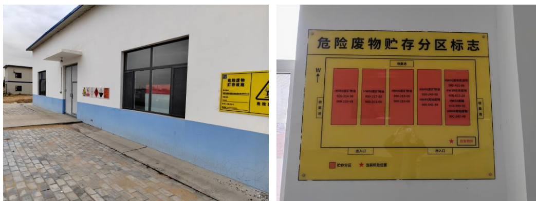
图 11.2-1 危险废物暂存库
