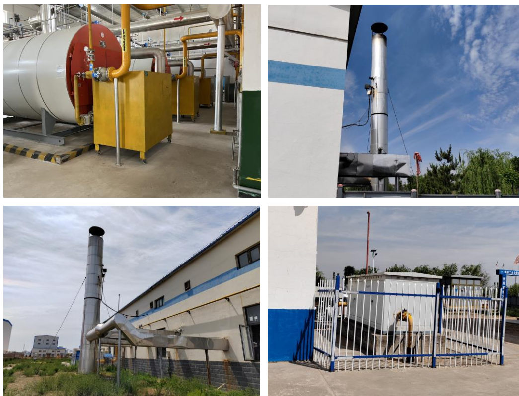
图 9.3-1 锅炉房现状照片
